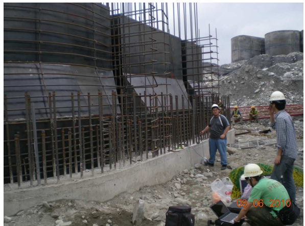
圖 8 花蓮壽豐溪橋現地檢測橢圓形複合式沉箱之照片
