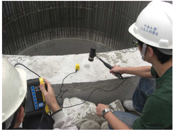
圖 7 花蓮壽豐溪橋現地檢測圓形沉箱之照片
