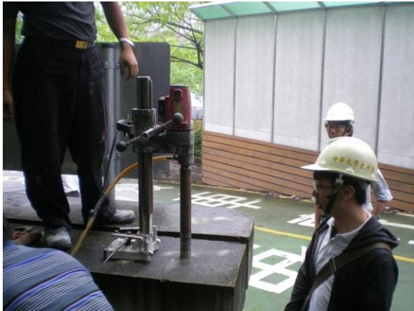
圖三 現地小型含樁帽基樁進行鑽蕊工程之照片
