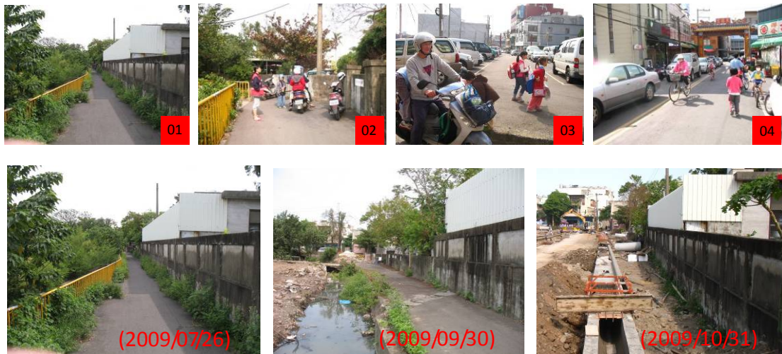
圖 4-2-6 圍牆西側圳道通學路
